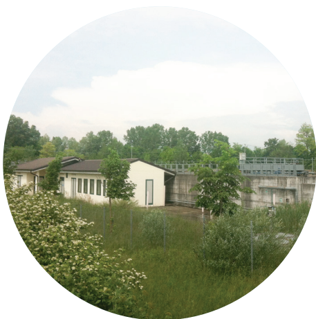
situazione di degrado del depuratore
